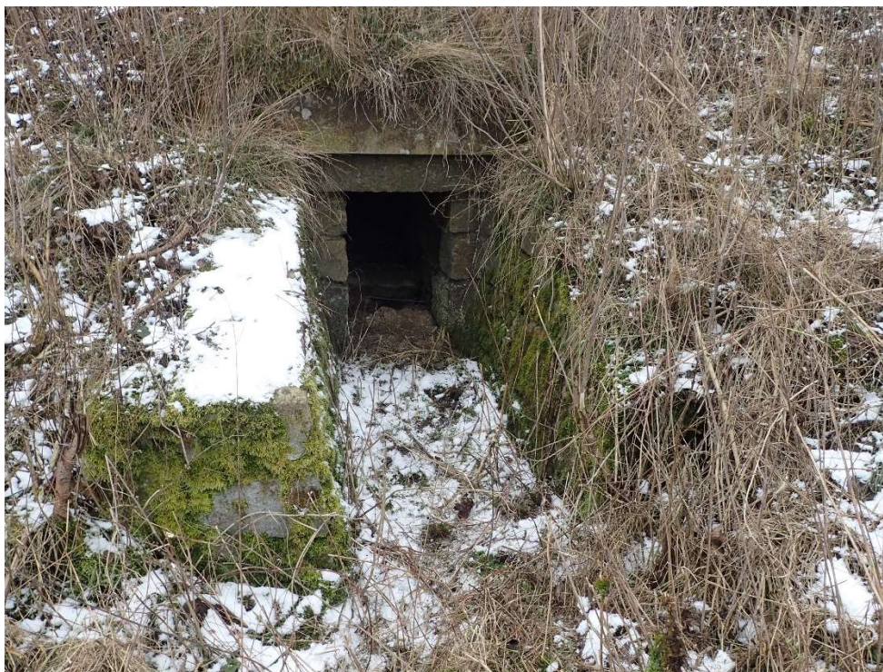
Foto 1: Pohled na výtok propustku
