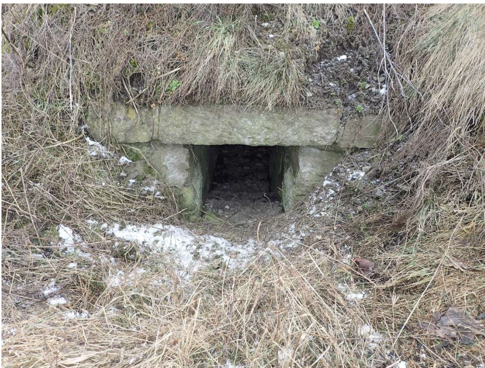
Foto 2: Pohled na vtok propustku
