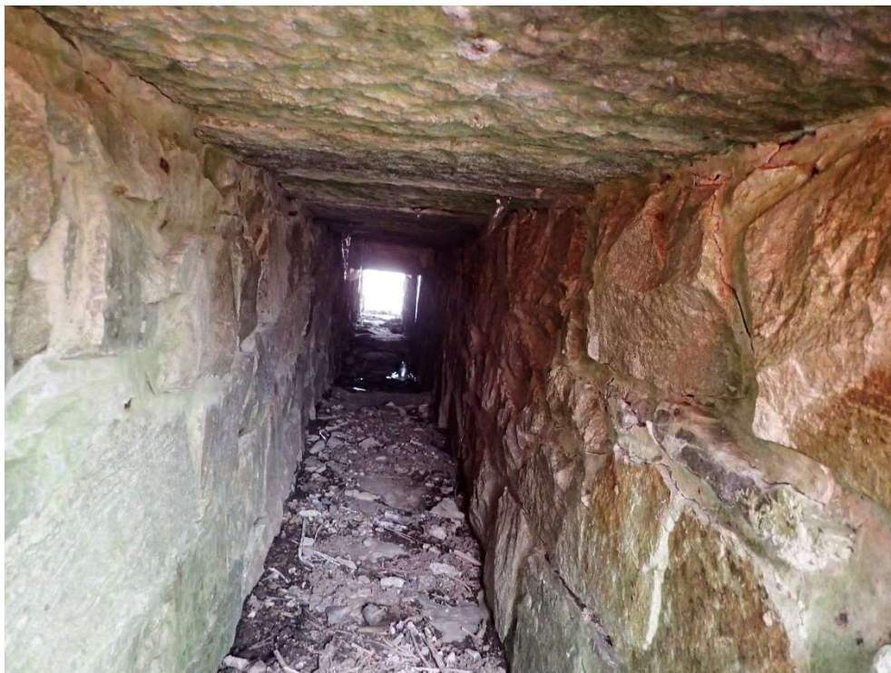
Foto 3: Znamky průsaku vody
